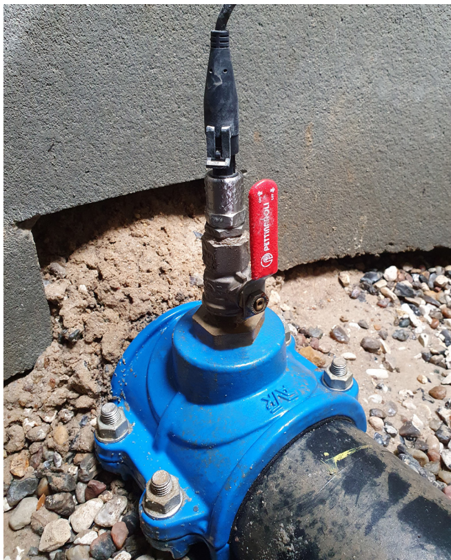
Vzhledem k bezdrátové povaze IoT lze tlakové senzory instalovat v jakémkoli kritickém bodě distribuční sítě a to i dodatečně.
