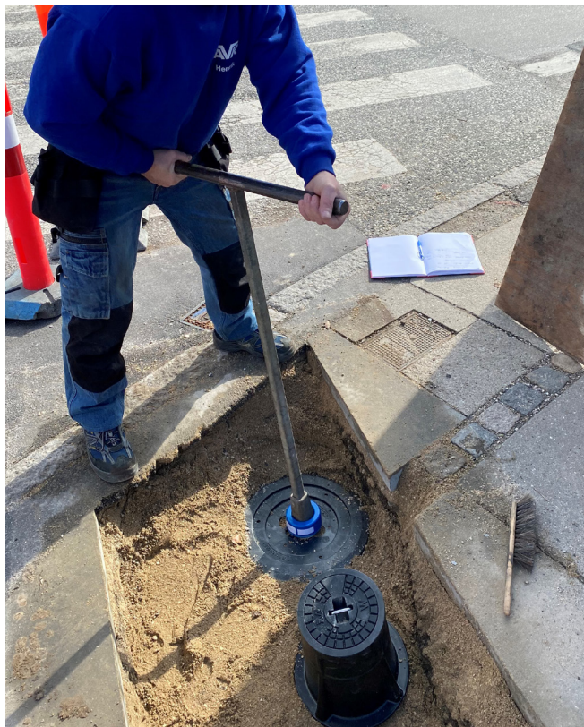
Šoupě se zemní soupravou s osazeným VIDI Pozicionerem, který detekuje, kdy je ventil v provozu.
